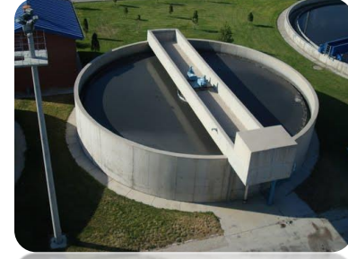
Ön Çöktürme Havuzu
